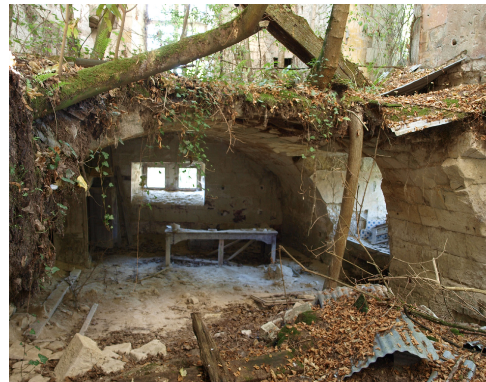
46. La volta sulle cucine. L'albero cresciuto sostiene parte della struttura
