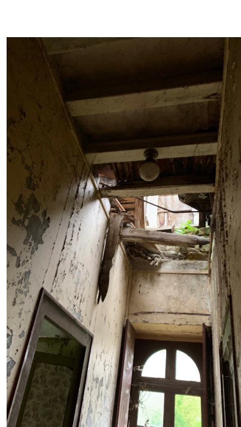
7. Stato di conservazione solaio
