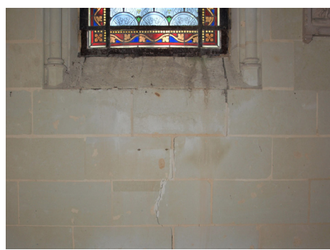
9. Dettaglio, fessura verticale, lato Est
