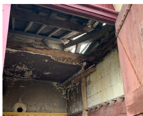
9. Stato della carpenteria di copertura
