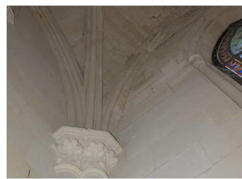
8. Dettaglio dell'imposta della volta
